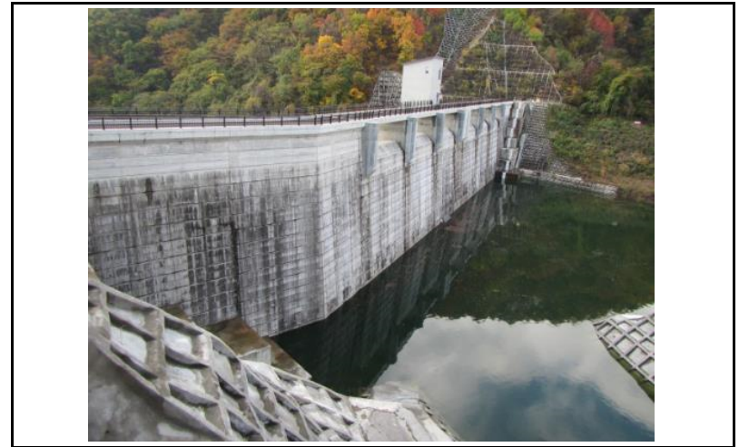
2 ダム上流面(左岸から)
