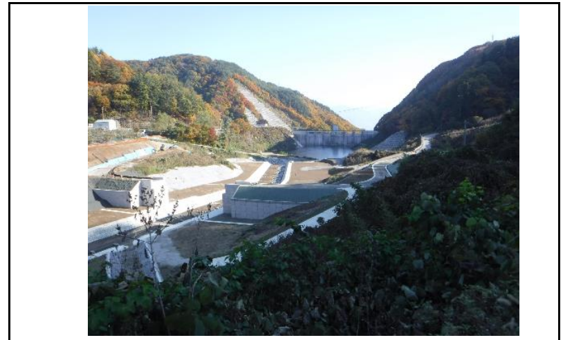
4 貯水池(上流からの全景)
